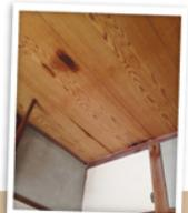
雨漏りによる天井の染み
