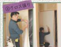
④クロス張り 一気に貼っていきます。
