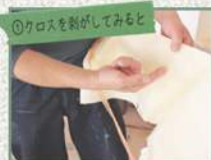
①クロスを剥がしてみよう 既存のクロスの薄い層が、パテで下地処理、これが命。剥がれ残り、凹凸の原因に。
