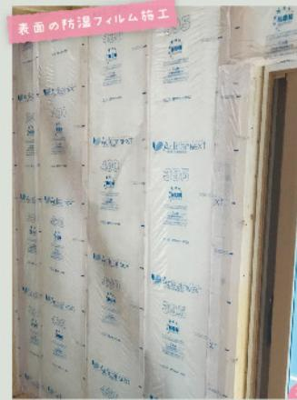
① 断熱材は、各所共隙間なく均一に充填することが大切です。当たり前だと思われるでしょうが、実は簡単ではありません。壁内には筋違いなどの構造体や下地木材、配管や配線などの障害物もありますので、取扱には丁寧な仕事が求められます。計画段階で、各所の寸法に断熱材の厚さを考慮しておくことも重要です。
