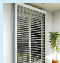
暑さ対策に効果が高いのが外部ブラインド。熱を開口部より外側で遮ることで高い遮熱効果がありますが、本格的な商品は電動のため工事費が高めになります。外側遮熱アイテムとしてオーニングテントも効果的ですが、西面などの低い角度からの日射の遮熱には適しません。
