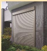
既存の窓に後付けで雨戸やシャッターを取り付けることが出来ます。耐風、断熱、電動(シャッターのみ)などの様々なタイプの資材が流通していて、数時間から数日程度で取付けできます。ただし、窓の周りに取付けが可能な余白が必要で、位置によっては足場などの設置が必要となる場合もあります。
